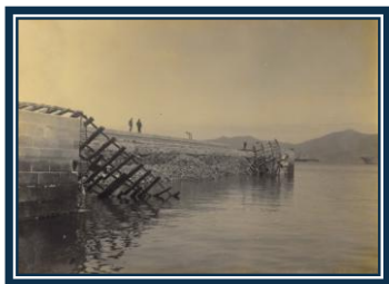
IMAGEN DE LA CUBIERTA: Hundimiento del Muelle Transversal Fotografía: Gil, 1915 Archivo General del Puerto de Vigo
