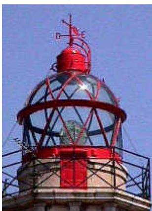
La parte superior se cerraba con una cúpula metálica, generalmente de cobre, abierta en la parte superior para que hubiera ventilación. Cuando la cubierta era transparente, la porción de luz que escapaba por ella servía también de guía a la navegación aérea, utilizándose para ello sistemas ópticos especiales, a este tipo de linternas se las denomina "aeromarítimas".
