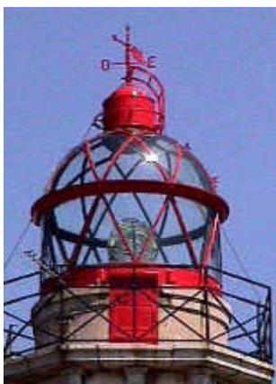
La parte superior se cerraba con una cúpula metálica, generalmente de cobre, abierta en la parte superior para que hubiera ventilación. Cuando la cubierta era transparente, una porción de luz se desviaba hacia arriba, para servir también de guía a la navegación aérea, para ello se utilizaban sistemas ópticos especiales, a este tipo de linternas se las denomina "aeromarítimas".
