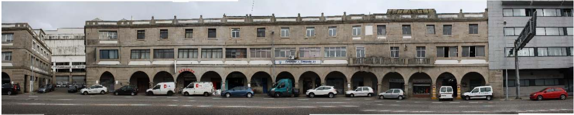
Fachada a Avenida Beiramar
