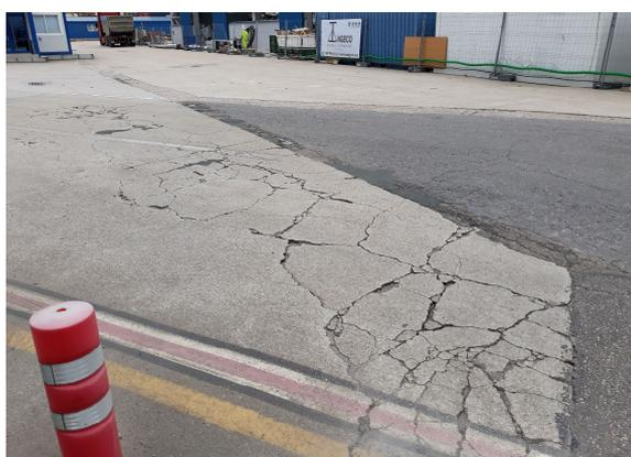
05. Pavimento rígido totalmente fracturado
