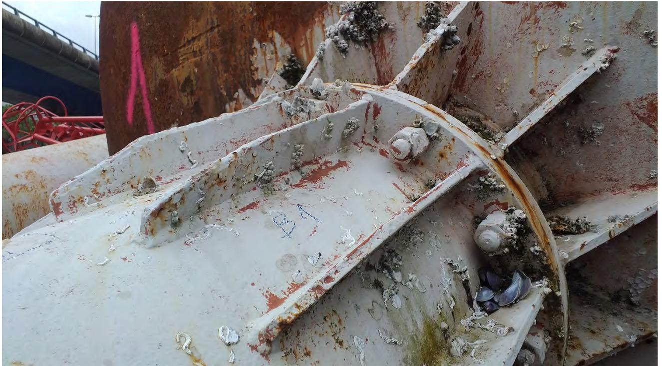
*Detalle de unión con rigidizadores entre casco inferior y cola de boya 1*
