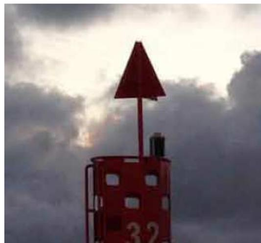
La linterna, el reflector de radar (salvo que esté integrado en la marca de tope) o cualquier otro elemento, nunca deben estar por encima de la marca de tope.
