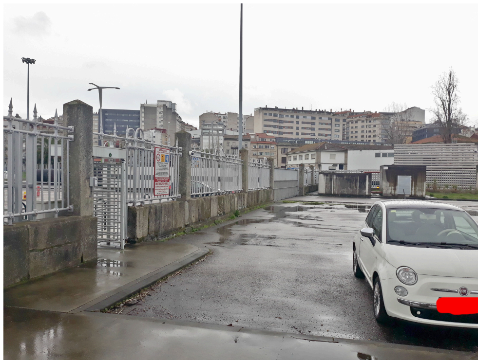
04. Vista del encuentro de la acera de hormigón con el pavimento de aglomerado. Al fondo se aprecia el portal de corredera a trasladar y en primer plano el torno peatonal.
