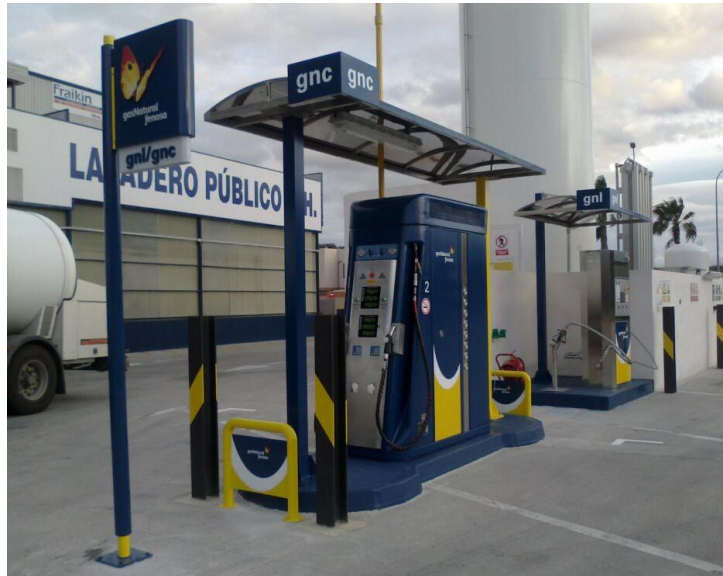
Figura 3. Surtidor de GNL/GNC en Málaga ( www.cadenadesuministro.es )
