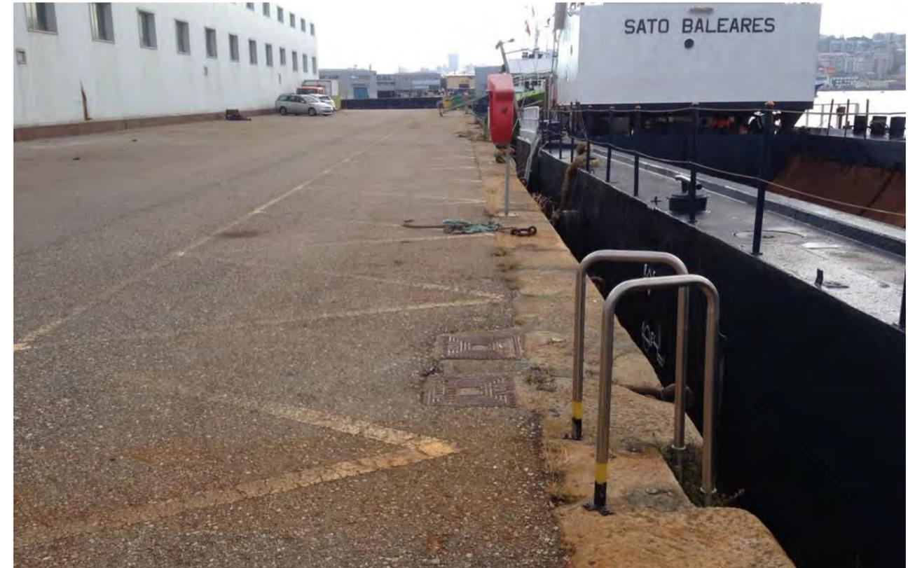
Foto 5. Imágenes del muelle Norte de la Dársena Nº2 de Bouzas. Presencia de red eléctrica antigua próxima al cantil.
