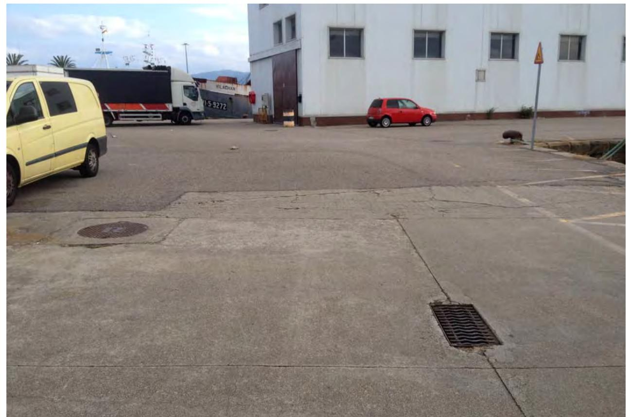
Foto 4. Imágenes del muelle Oeste de la Dársena Nº2 de Bouzas. Presencia de redes de abastecimiento y electricidad por el cantil, red de drenaje por el centro y red de telefonía próxima a la fachada de la nave existente.
