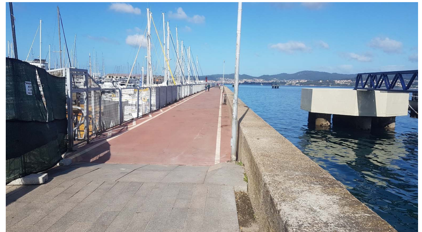
Figura 4. Fotografía nº 4. Arranque de la actuación en el lado del espigón
