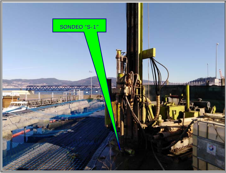
Emplazamiento del sondeo "S-1"
