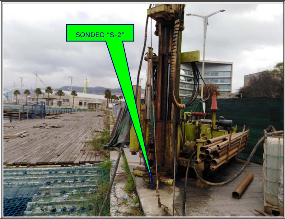
Emplazamiento del sondeo "S-2"
