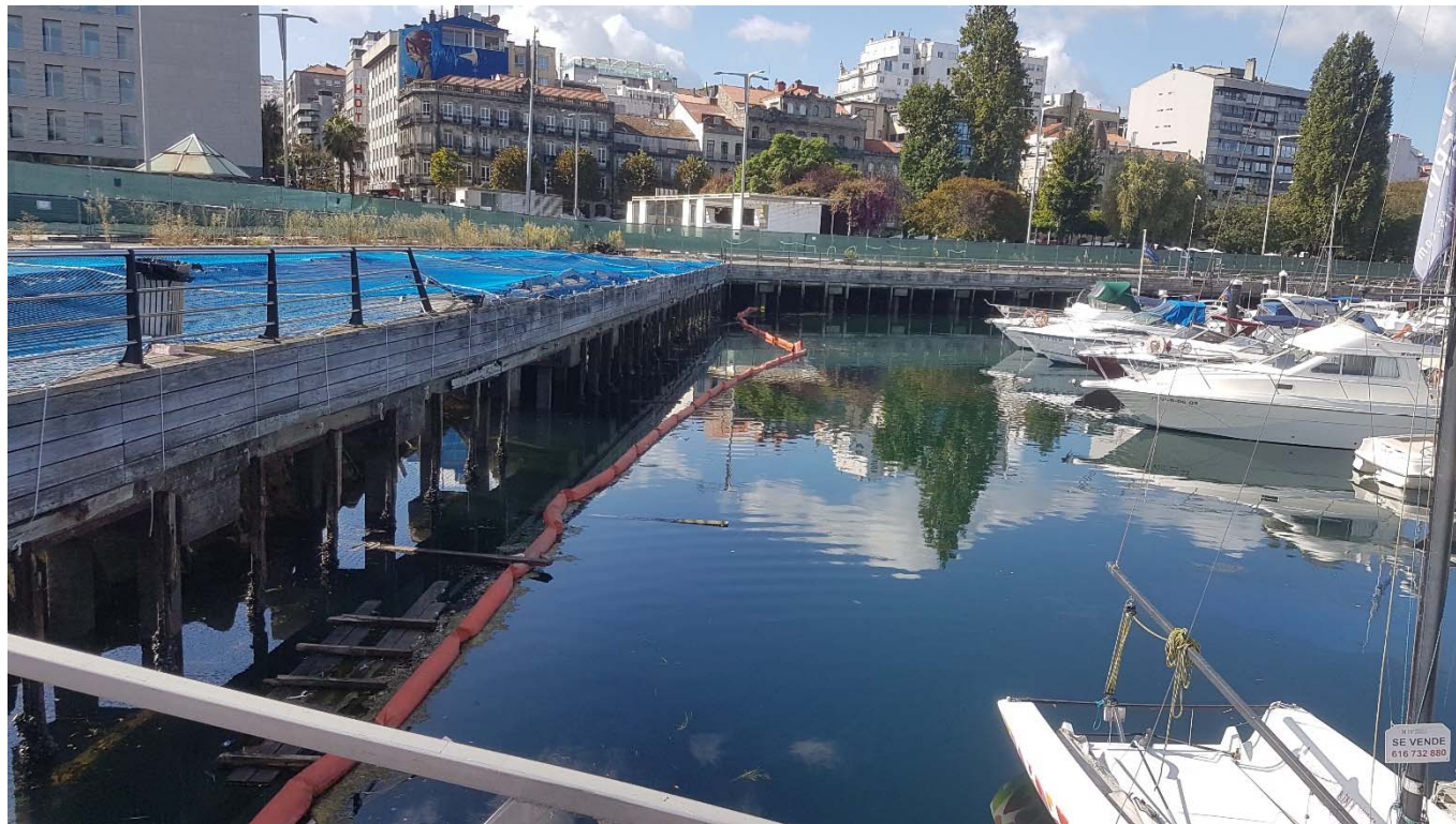
Figura 1. Fotografía nº 1. Estructura vista desde el espigón de la dársena del RCNV
