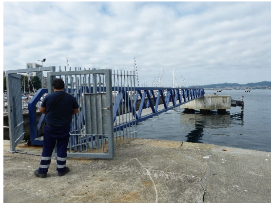
Imagen. 18. Vista celosía desde muelle de comercio.
