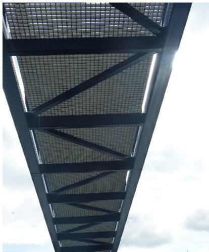
Imagen. 7. Paramento inferior pasarela, vista hacia muelle.
