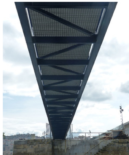
Imagen. 8. Paramento inferior pasarela, vista hacia muelle.
