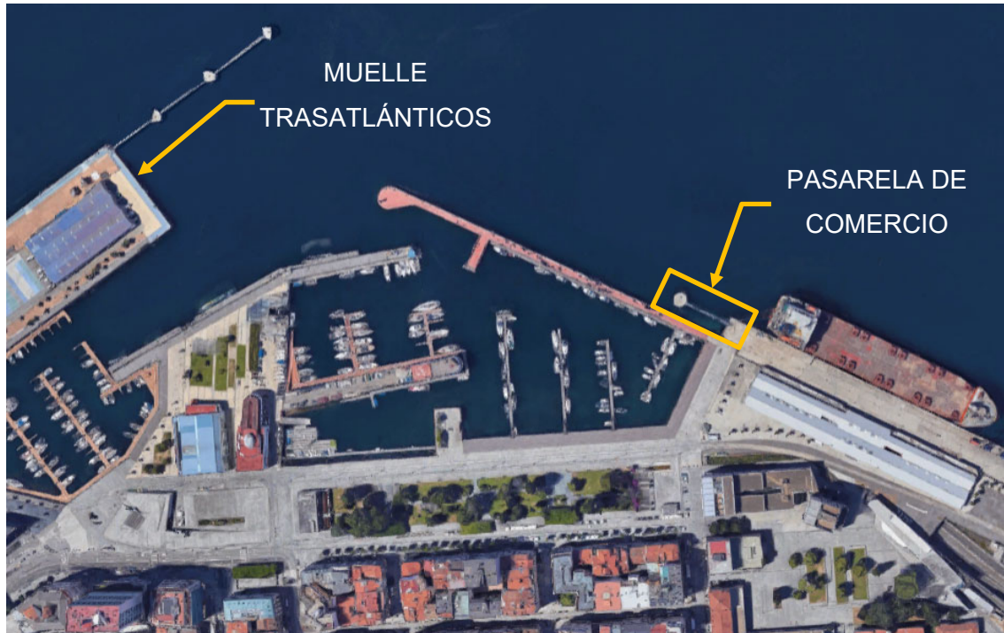
Imagen. 1. Imagen aérea de la pasarela de comercio (Imagen extraída de Google Maps).
