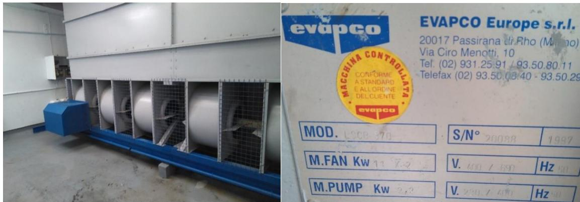
Condensador evaporativo marca Evapco mod. LSCB-370 y placa característica.
