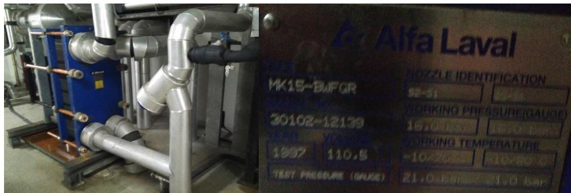
Intercambiador NH<sub>3</sub>-H<sub>2</sub>O marca ALFA LAVAL mod. MK15-BWFGR y placa característica.
