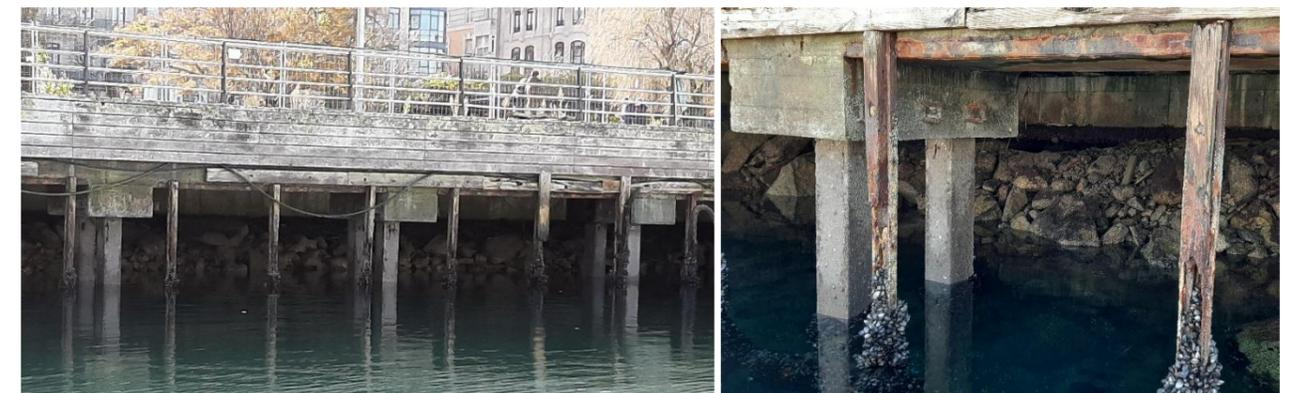
Figura 5. Imagen de la estructura desde la dársena (izquierda). Detalle de los encepados y estructura auxiliar (derecha)
