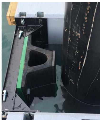
Figura 1. Detalle de la defensa tipo Prosertek TTV
