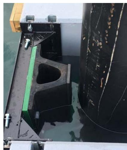
Figura 16. Detalle de la defensa tipo Prosertek TTV
