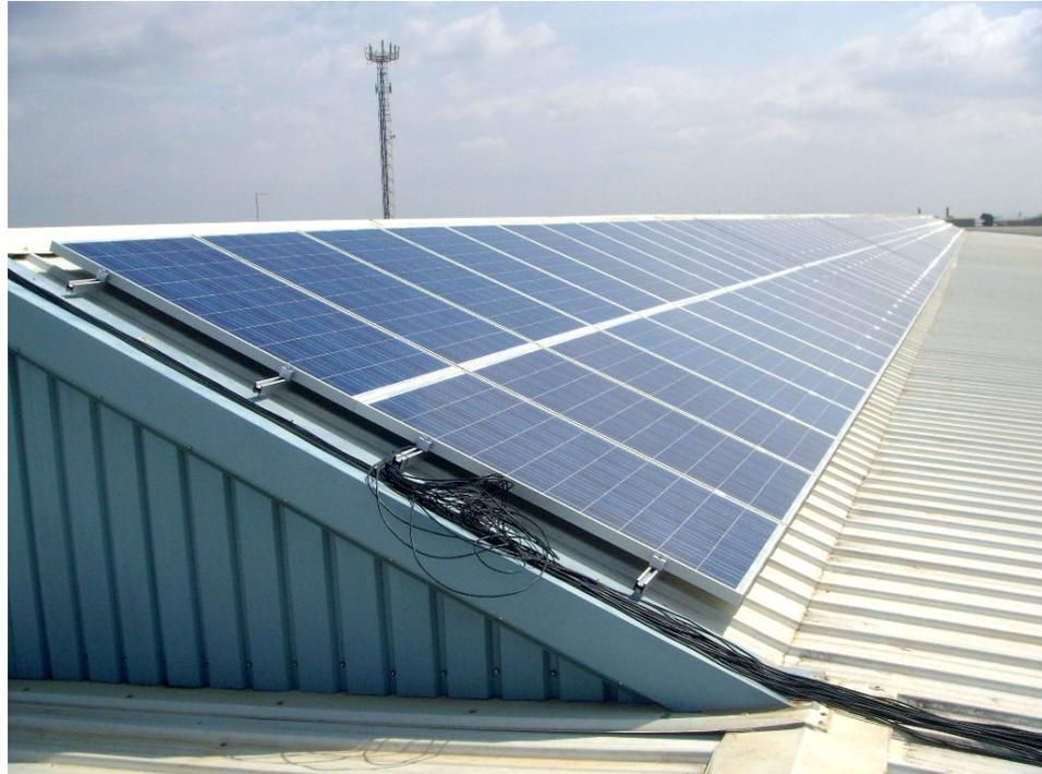
**Figura 15. Estructura soporte de los paneles fotovoltaicos**
