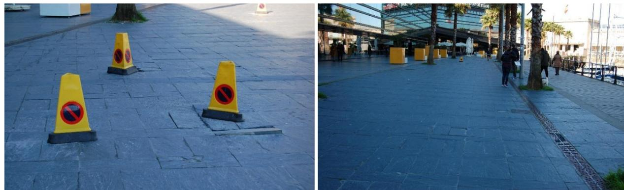
Figura 6. Imagen del pavimento de pizarra y zonas con desperfectos en la zona de la darse de A Laxe
