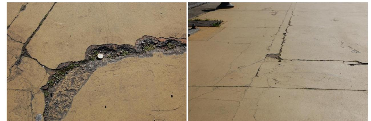
Figura 3. Imagen de desperfectos en la zona de hormigón coloreado
