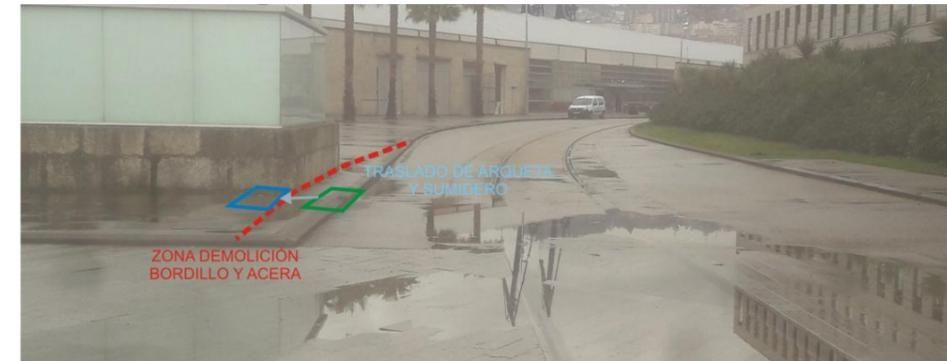
Figura 27. Imagen de la zona de demolición y desplazamiento de la arqueta y sumidero
