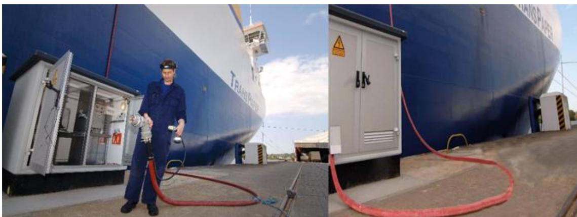
**Figura 24.** Procedimiento de conexión (izquierda) y buque conectado a un OPS en una caja de conexiones vertical (derecha).
