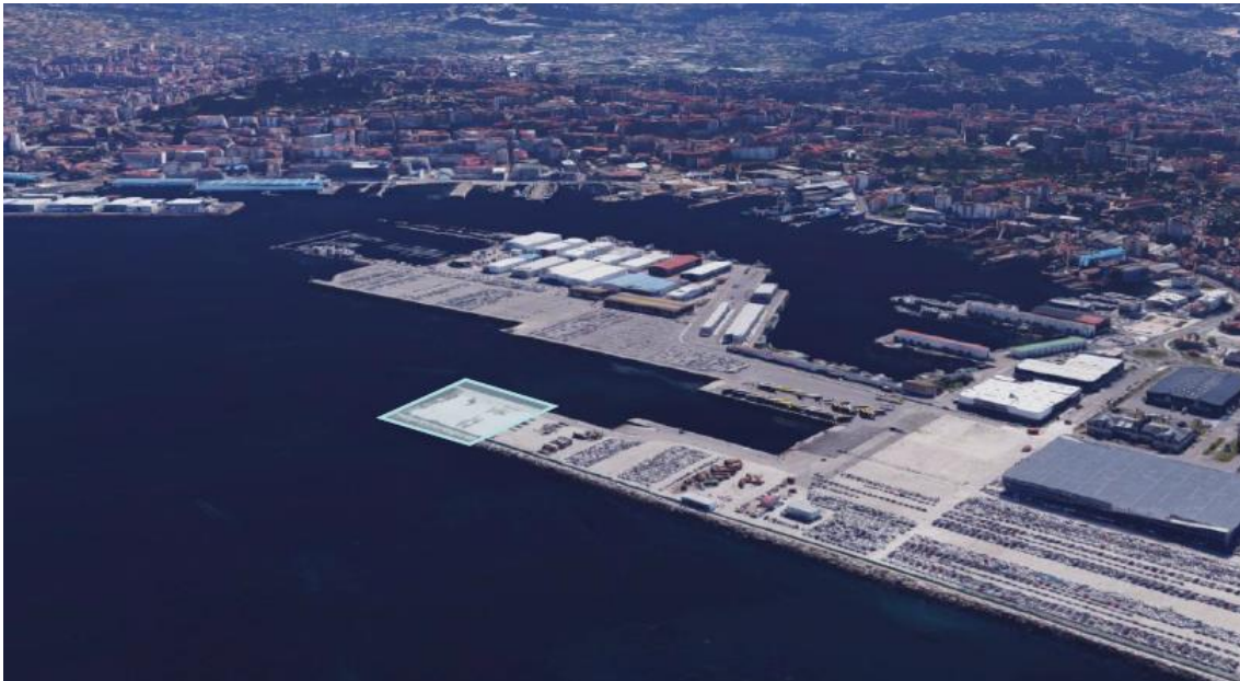
Figura 41. Vista aérea de la entrada a la zona portuaria de Vigo, resaltando la ubicación de la Terminal SSLNG. Fuente: Reganosa Servicios, Autoridad Portuaria de Vigo [15].
