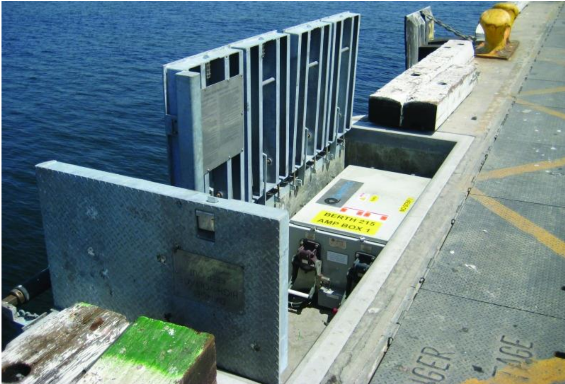
Figura 13. Caja de conexión enterrada AMPVault. Fuente: Cavotec.
